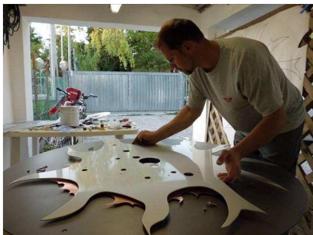
Foto 2 - I raggi grandi in alluminio del sole sono fissati su sette perni sopraelevati rispetto a quelli in rame.
