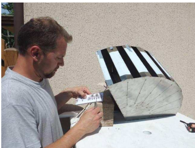
Foto 8 - I pannelli fotovoltaici sono collegati ad una centralina.
